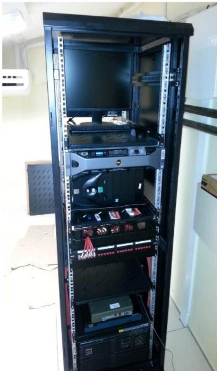
Figura 2: Exemplo de montagem rack fechado
